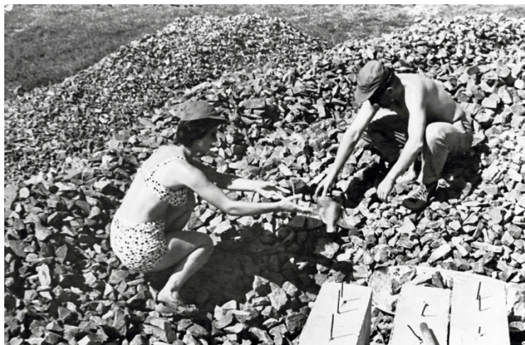
V nastalém období úžasného „babiho léta“ stál před stavebníky-chataři nelehký úkol - upravit terén před hangárem, včetně přípravy štětového podloží pro budoucí manipulační plochu; Nový Dvůr, říjen 1964
